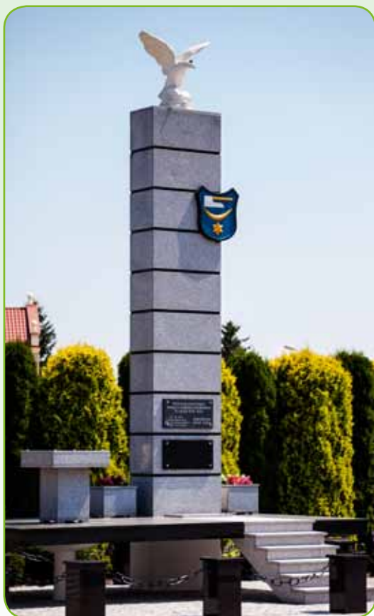
Renowacja pomnika Poległych za Ojczyznę Gmina Żabno
