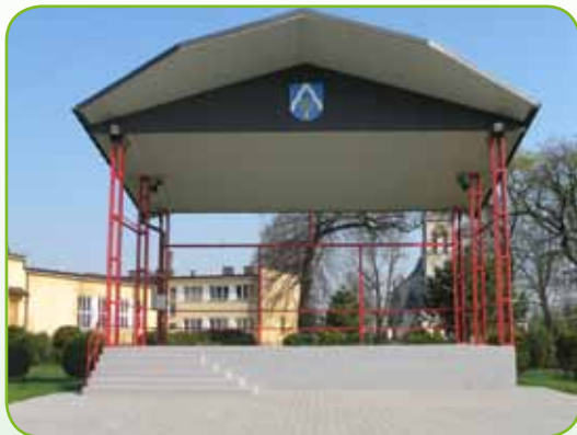
Remont Sceny Widowiskowej Gmina Wietrzychowice
