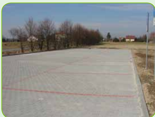
Wykonanie parkingu w Rudce Gmina Wierzchosławice
